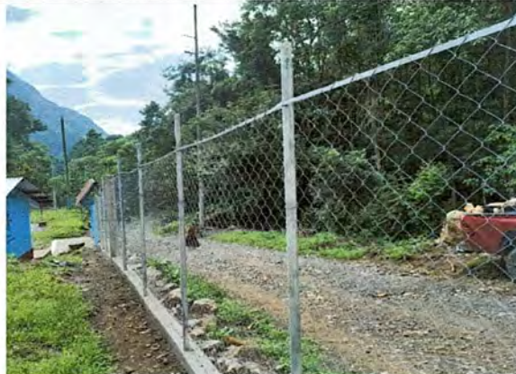
Foto 2: avance en la colocación de muro perimetral
