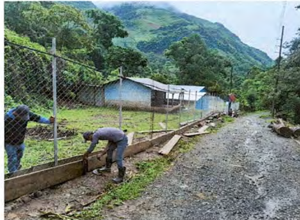
Foto 4: Avance en muro perimetral
